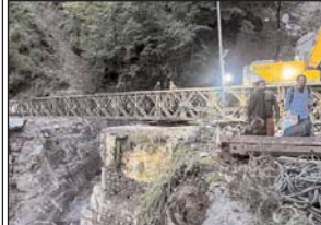
गंगोत्री राष्ट्रीय राजमार्ग पर लिमचागाड के गंगनानी के पास घाटी पुल का निर्माण कार्य चल रहा है।
