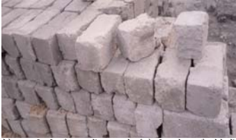
केदार । मिस्त्री और मजदूरों द्वारा कार्य किया जा रहा है। भवन निर्माण में गुणवत्तापूर्ण ढाँचा प्रयोग किया जा रहा है। वहीं कई महीने तक रहने से जम चुके सीमेंट का उपयोग होत
